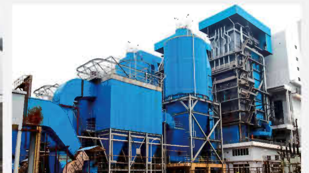
绍兴垃圾和污染处置综合利用工程
