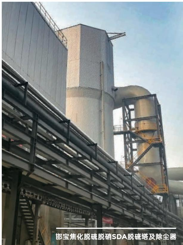
邯宝焦化脱硫脱硝SDA脱硫塔及除尘器
