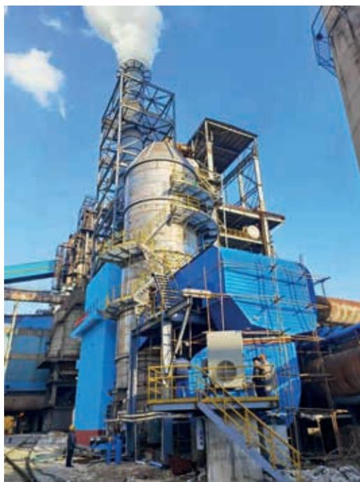
这是中钢天澄EPC总承包的、也是河北省首台套采用钠碱法湿法脱硫工艺对高炉热风炉进行治理的项目。项目采用氢氧化钠湿式脱硫工艺，烟气经处理后，将达到最严格的超低排放标准：出口SO<sub>2</sub>浓度<35mg/Nm<sup>3</sup>；颗粒物指标<10mg/Nm<sup>3</sup>。该工艺不仅脱硫、除尘效率高，且可以适应高炉热风炉各种不利工况、保持安全运行。更令人期待的是，该工艺无废水、废渣外排，脱硫液经过强制氧化后进入高炉冲渣水循环利用。
