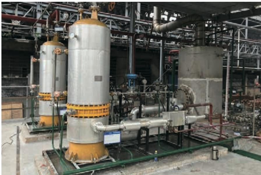
柳钢焦化一焦烟气脱硫脱硝装置氨区设备
