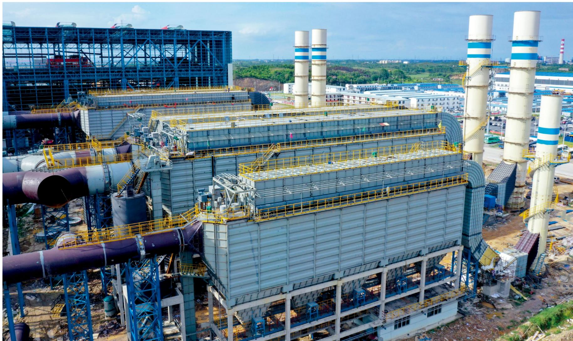
中钢天澄提供的工业窑炉烟尘细颗粒物超低排放技术及装备。
